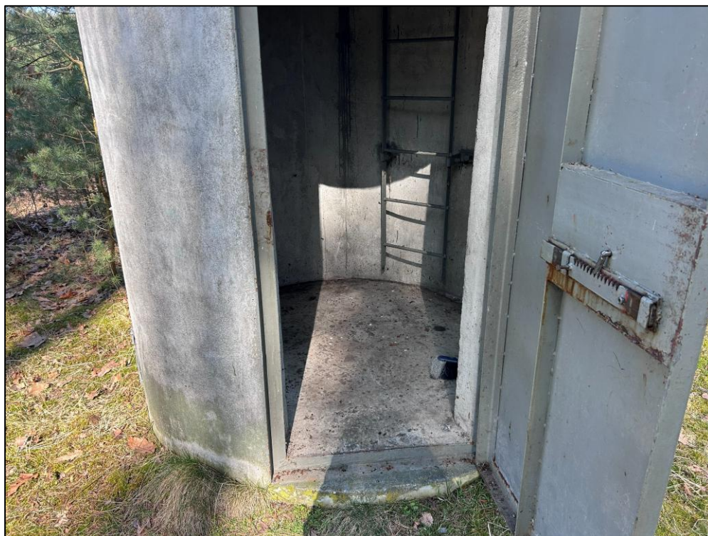
Zdjęcie nr 6 Trzon żelbetowej wolnostojącej dostrzegalni ppoż. Na powierzchni zewnętrznej powierzchniowe zabrudzenia koloru ciemnego i jasny materiał betonu rodzimego. Metalowe drzwi wejścia do układu komunikacyjnego i pionowy zwód instalacji odgromowej przechodzący do wnętrza trzonu.
