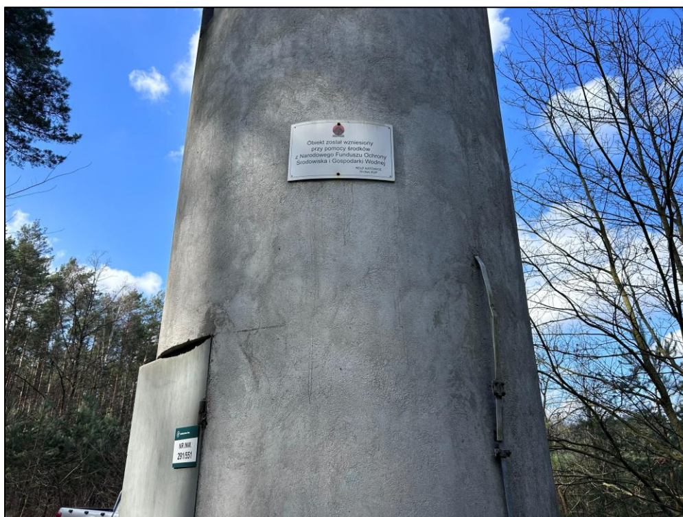
Zdjęcie nr 6 Trzon żelbetowej wolnostojącej dostrzegalni ppoż. Na powierzchni zewnętrznej powierzchniowe zabrudzenia koloru ciemnego i jasny materiał betonu rodzimego. Metalowe drzwi wejścia do układu komunikacyjnego i pionowy zwód instalacji odgromowej przechodzący do wnętrza trzonu.
